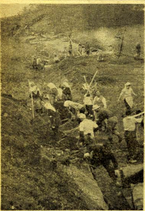
(写真は植苗駅前道路改良工事に汗を流している人々)
