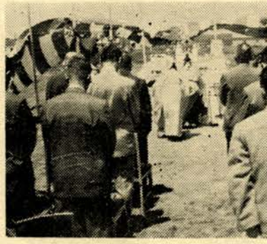
日本ライヒホールベニヤなどの接着剤生産 建設工事始まる
