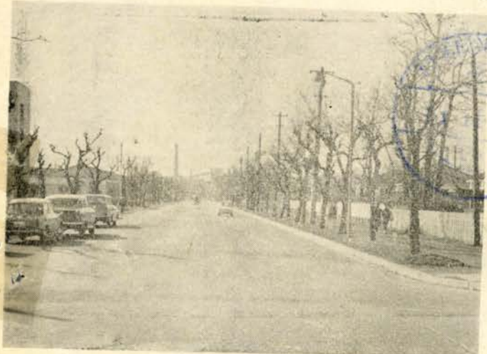
八月十五日から着手していた市道王子通り線の舗装工事がさい
