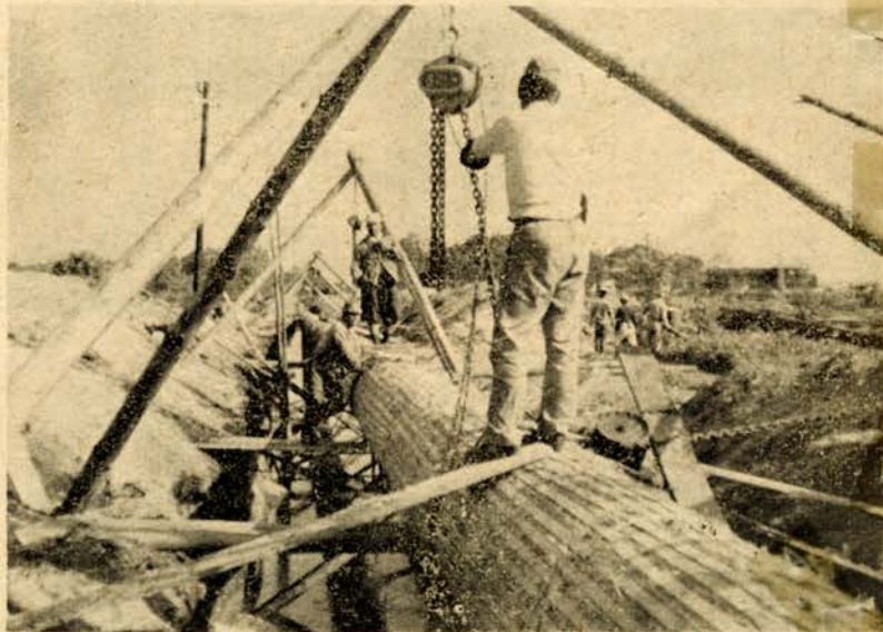
○…布設されようとする800ミリ径の巨大な配水本…○ ○…管。良質の水が豊富に市民の台所に送られます…○
