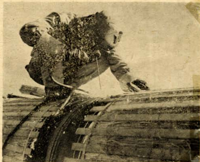
○…配水本管は、一本十二メートルで日本でも始めて…○ ○…製作されたものです。この鋼管を電気溶接…○ ○…して、その部分をレントゲンで検査して完…○ ○…全であることを確かめてから布設します。…○
